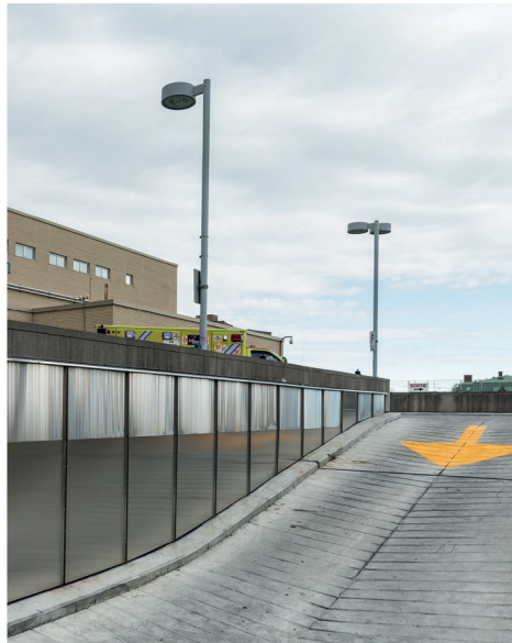
HÔPITAL NOTRE-DAME | RÉFECTION DU TABLIER DE L'URGENCE
